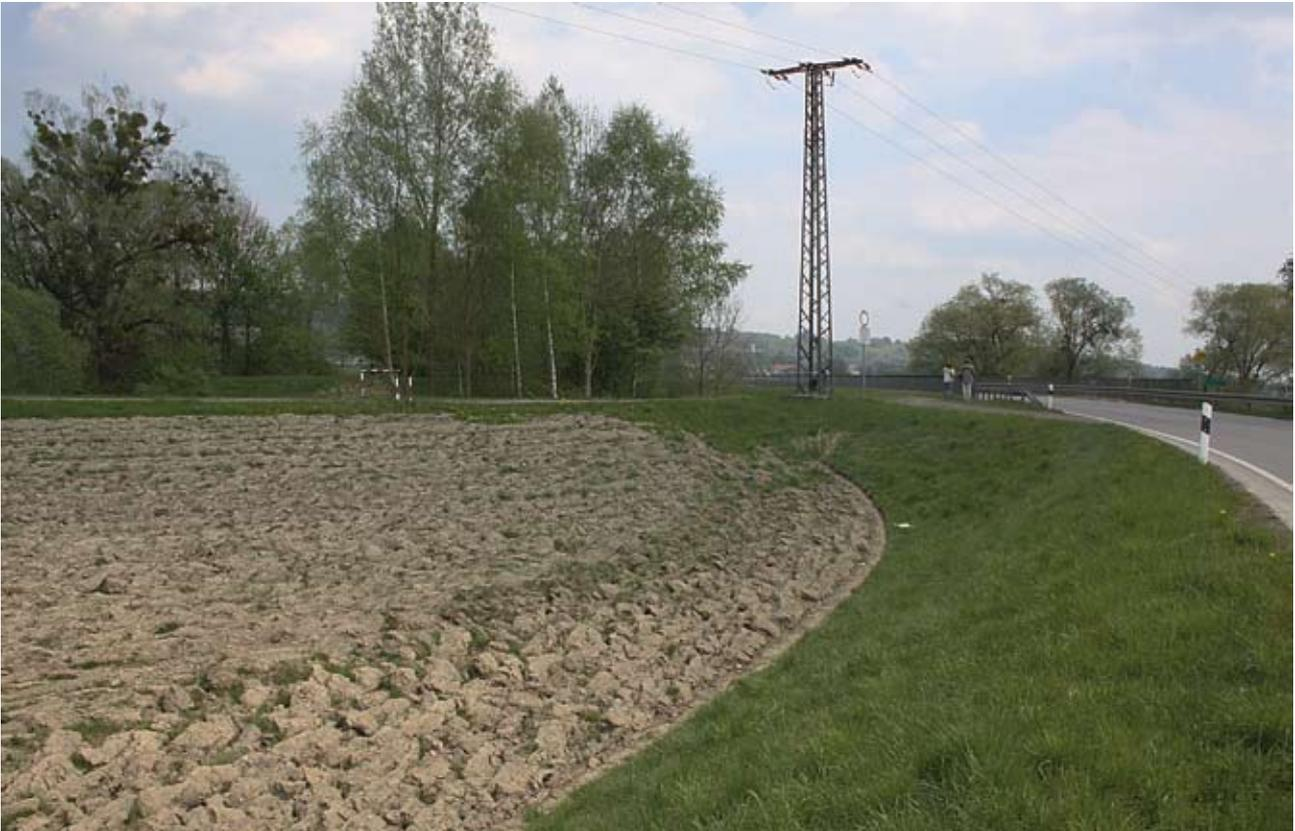
Abb. 8: Fast bis zur Krone beackelter Deich an der Ammer unmittelbar nördlich der Brücke der Straßenverbindung Pähl-Raisting, Blickrichtung Ost.
