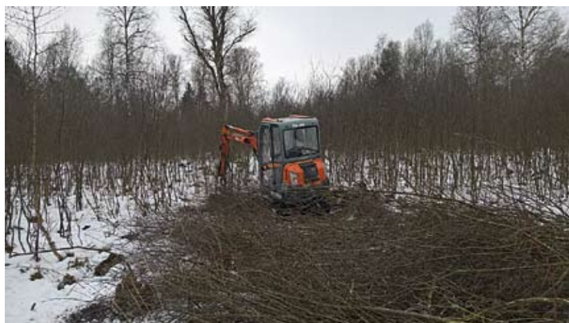
Einbau von gerodetem Material als Matratze für den Bagger
