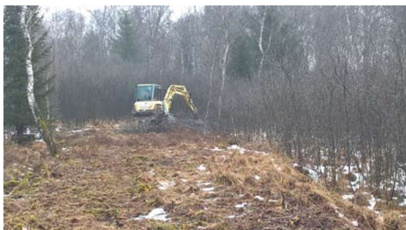
Bagger mit Sortiergreifer bei den Rodungsarbeiten
