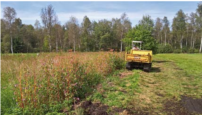
Materialtransport mit Dumper, die Springkrautbestände wurden gemulcht
