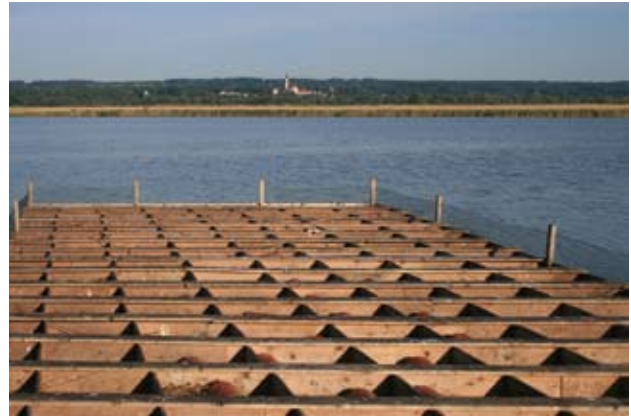
Abb. 2: Nistfloß Ammersee-Süd mit Brutflächen-Neubau 2008. Nur mehr die bewährte Reviergröße von 0,66m 2 ist vorgegeben Fotos: Heribert Zintl
