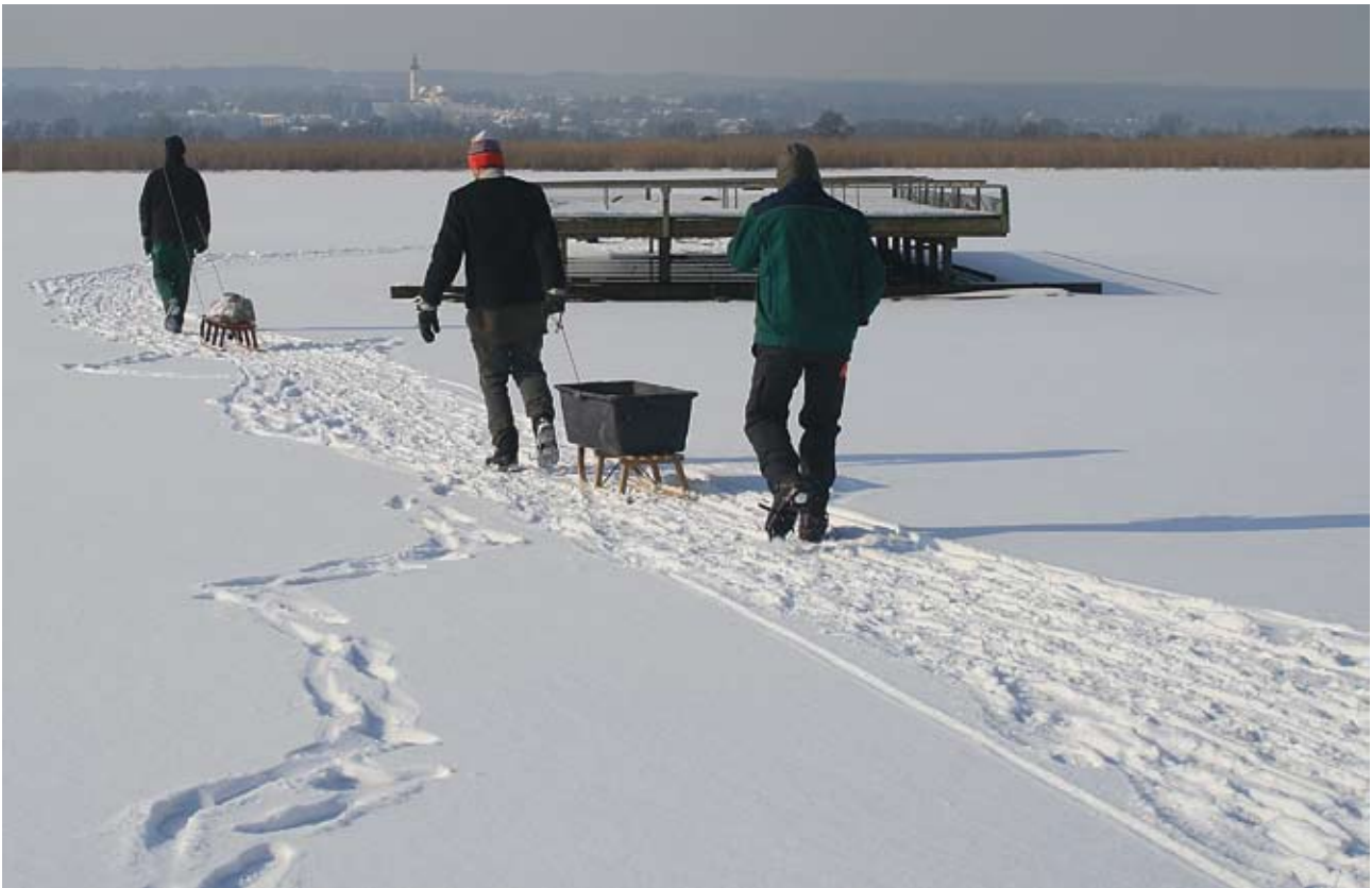
Vorarbeiten für einen Kastenanker (Gabione) zur Floßstabilisierung, Feb. 2012
