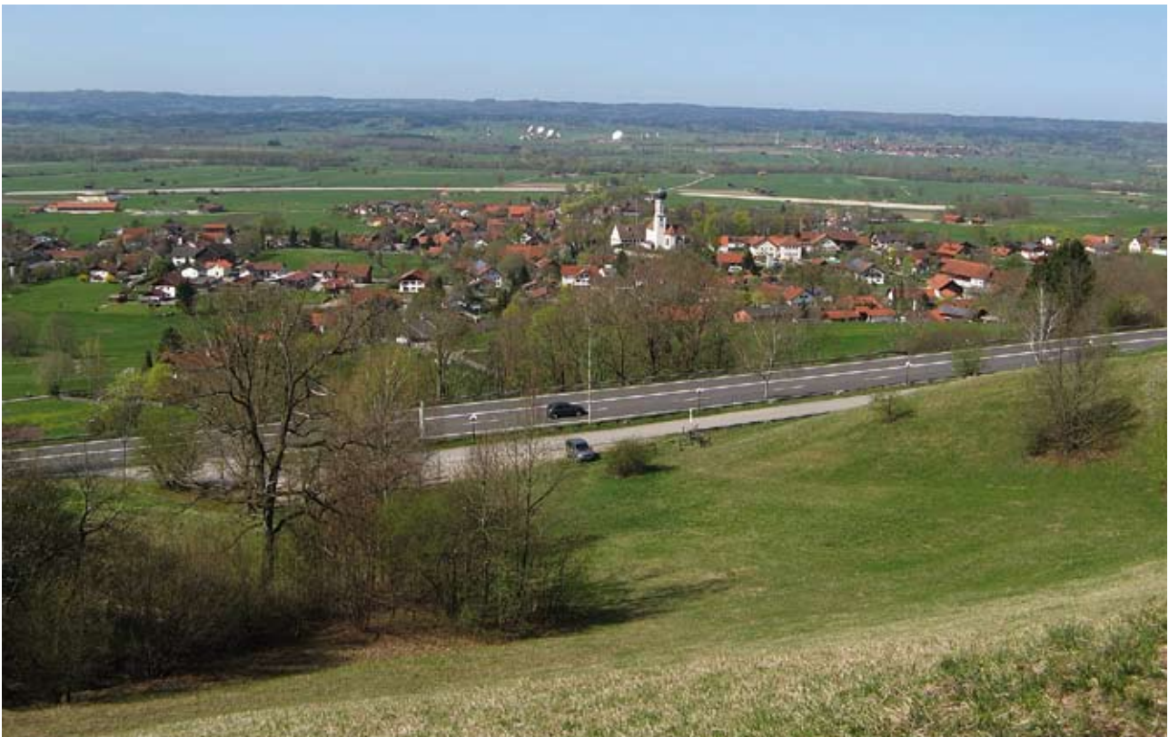
Im Hintergrund der die Landschaft durchschneidender Damm der Umgehungsstraße westl. von Pähl
