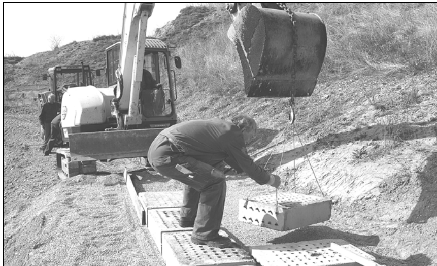
Setzen des Fundaments, im Vordergrund Karl Bregler
