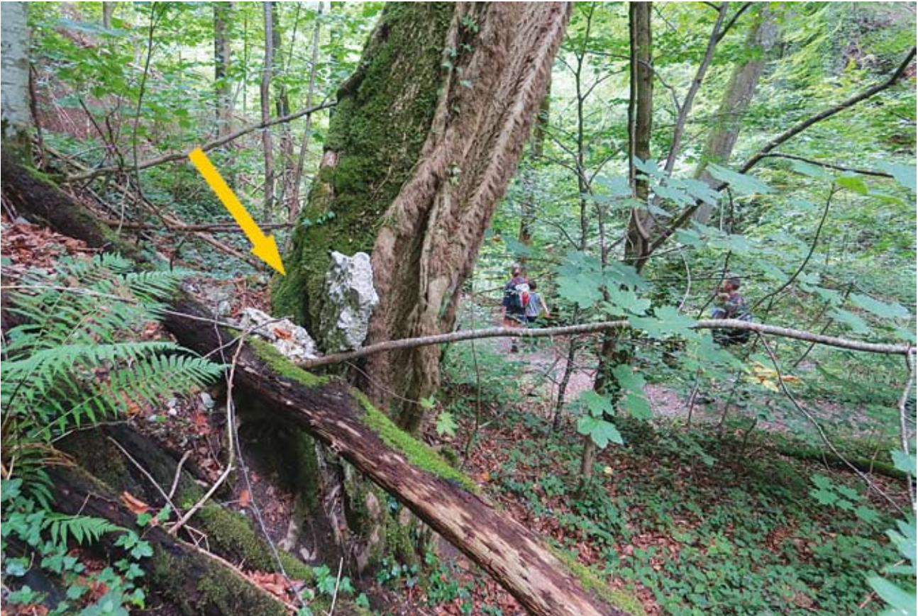
Die Gefahrenlage in der hinteren Pähler Schlucht auf dem Zugang zum Wasserfall ist nach wie vor sehr hoch! Zwei größere Steine sind aus der Wand gebrochen, diese wurden von dem Baumstamm abgefangen (direkt darunter sichtbar Besucher auf dem Weg).
