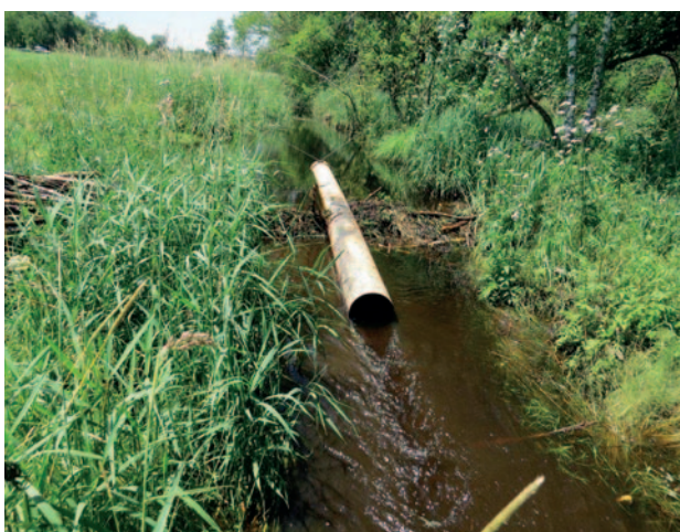
In den Biberdamm eingebaute Rohre, Fotos: Helmut Hermann
