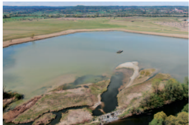
»Großer Binnensee«, Blickrichtung W. Das Bild zeigt die vorschreitende Verlandung, die nicht mehr weit vom Seeschwalben-Brutfloß entfernt ist. Die Überlaufschwelle (grau am unteren Bildrand) ist mittlerweile soweit abgesunken, dass bei jedem noch so kleinen Hochwasser-Ereignis Feinsedimente bzw. Schlamm in den Binnensee eingespült werden. (Foto: Bayerisches Landesamt für Umwelt, Maximilian Mitterbacher 16 , Mai 2021).
